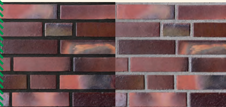
Gleicher Klinker, unterschiedliche Fugenfarbe
